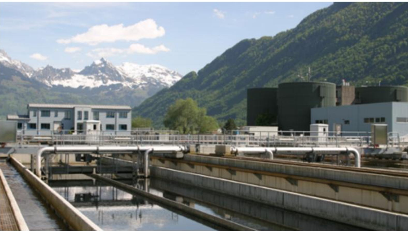
水和污水处理
